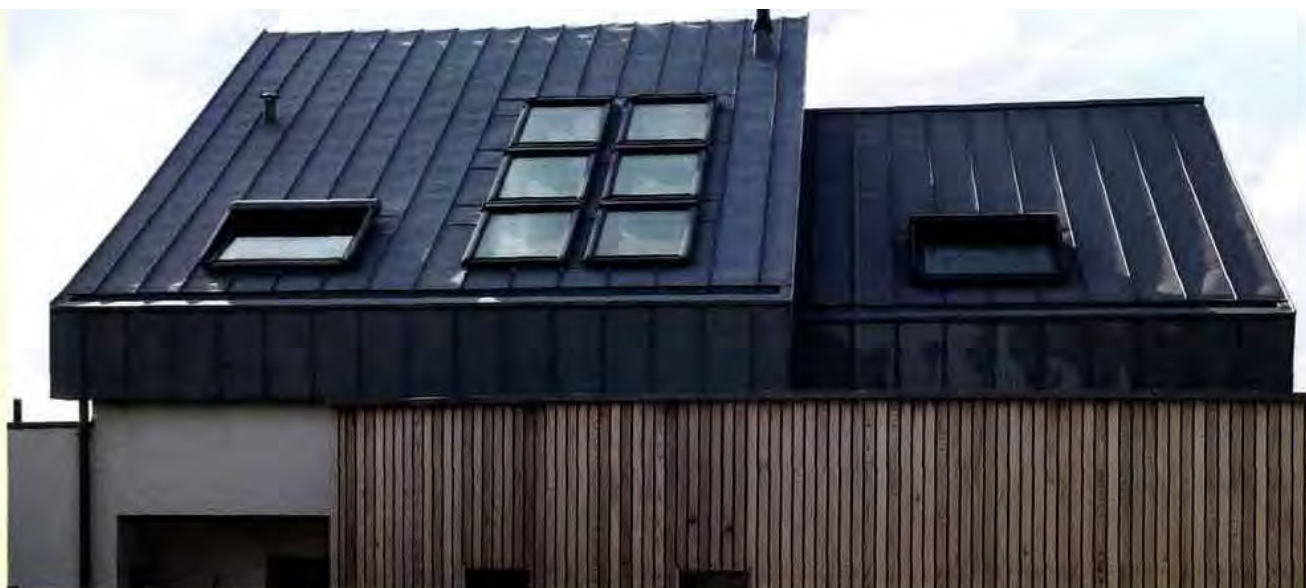
Le toit, véritable 5e façade, permet un important apport de lumière. La domotique permet de gérer automatiquement les stores en cas de fort ensoleillement.
